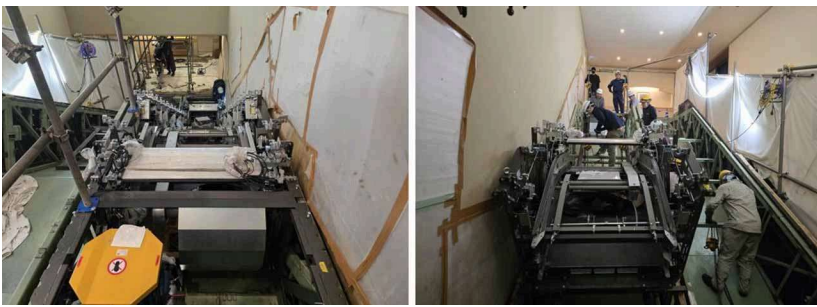
図8:ウインチを使用して、モジュールを指定された位置にドラッグして接続しました。
