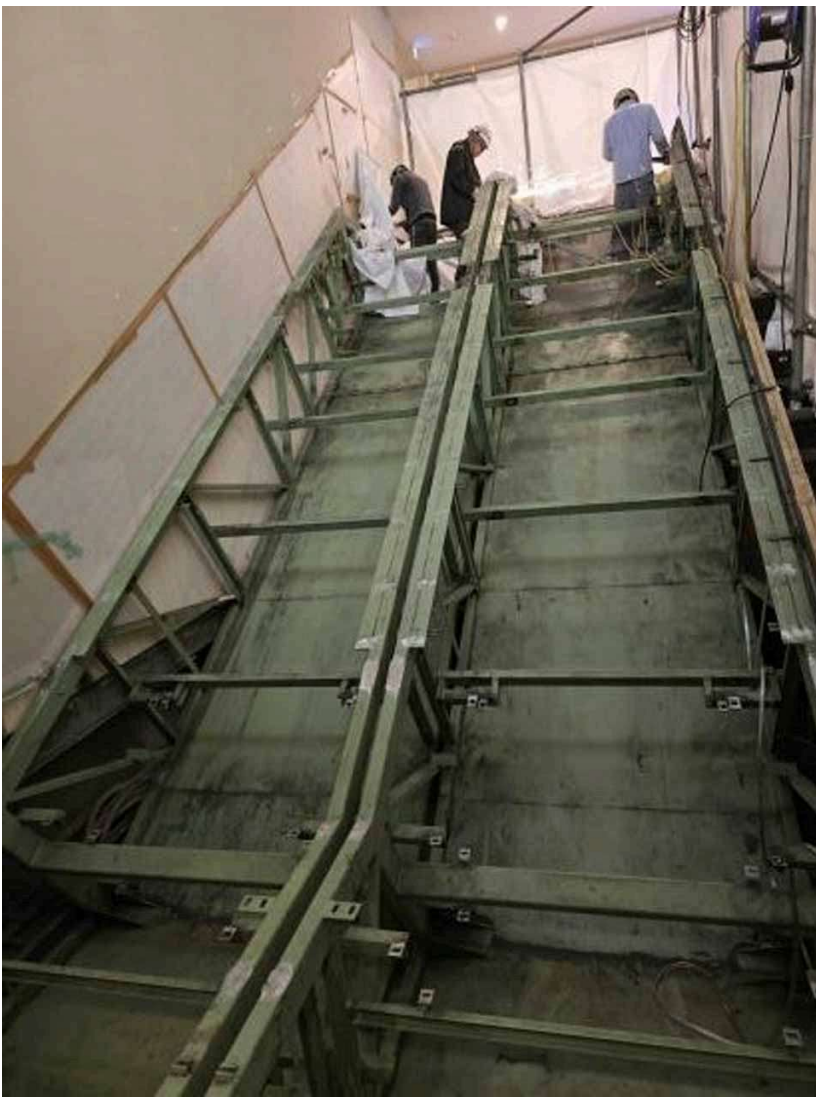
図6: 既存のトラスは完全に保存されていた。
